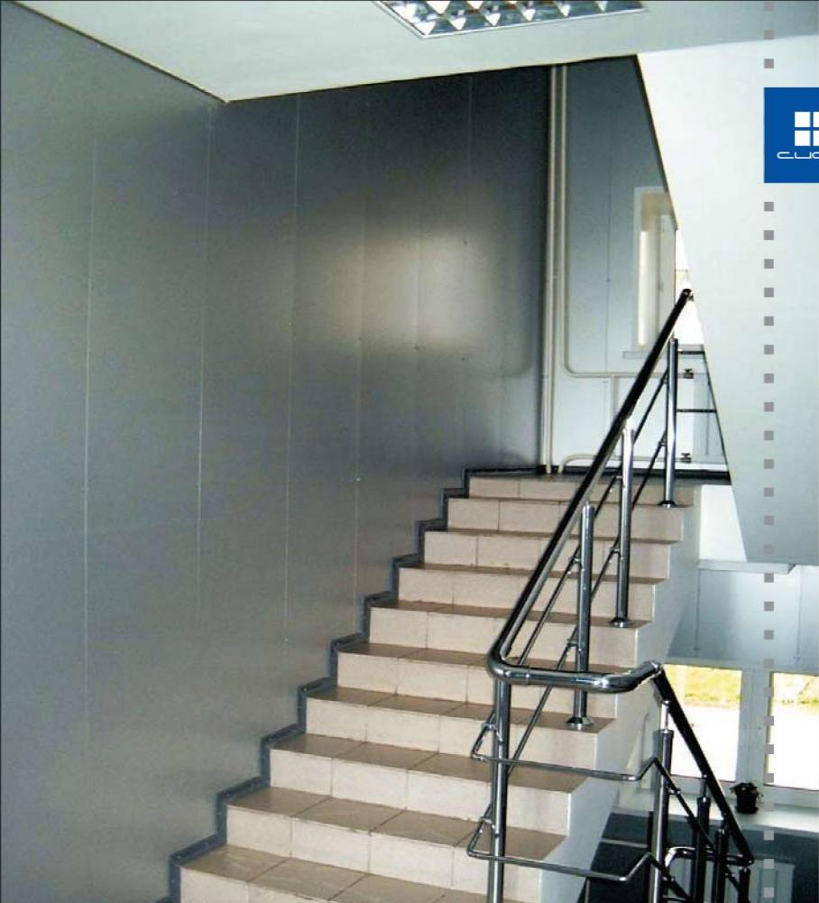
**Система** предназначена для облицовки внутренних стен помещений композитом с кассетным (скрытым) или заклепочным (видимым) креплением. Кронштейны используются только при необходимости выполнить тепло- или звукоизоляцию стены. Толщина конструкции без кронштейнов от 27 до 56 мм. С помощью этой системы можно выполнить достаточно сложные формы и объемы: облицовку колонн, объектов рекламы и др.
